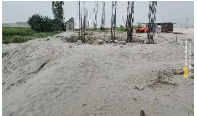
মেইন গেইট নির্মাণ
