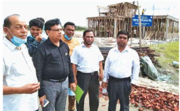
মাদারীপুর শিল্পনগরী সম্প্রসারণ প্রকল্পের উন্নয়ন কাজ পরিদর্শনকালে ড. গোলাম মোঃ ফারুক, পরিচালক (পরিকল্পনা ও গবেষণা), বিসিক
